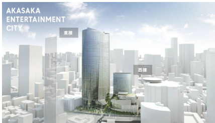
赤坂二丁目・六丁目再開発計画 2028年の竣工に向け、順調に工事が進行中。 東棟は鹿島建設、西棟は大林組の施工に決定。
